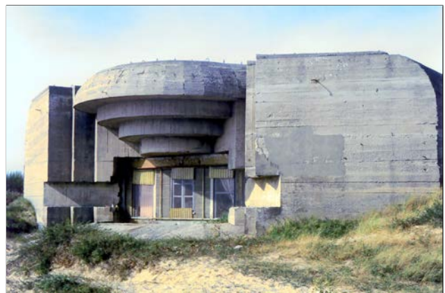
Abbildung 35: In Le Bois-Plage-en-Ré in der weiteren Umgebung der beschriebenen Stützpunkte befindet sich dieser Geschützstand; angeblich ein Regelbau M 272 für eine 15-cm-Kanone.
