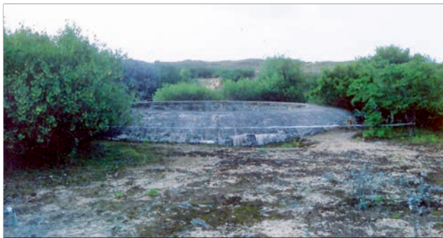
Abbildung 33: Turmschacht mit dem Beton-Turmkranz
